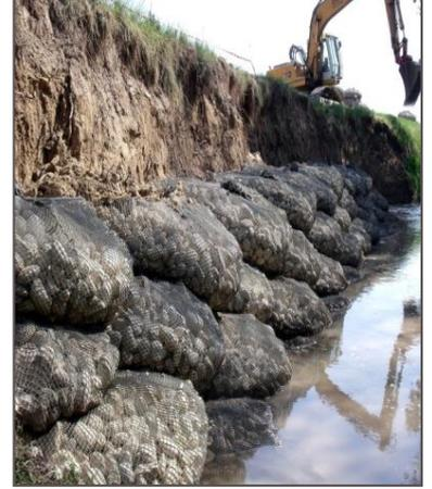
**Filet- Tex** est un filet synthétique de forme cylindrique , en grillage polypropylène traitées anti-UV , disponible dans des tonnages de 0,5 t, 1 tonne, 2 tonnes, 4 tonnes, etc...
